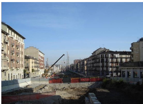
Figura 182 Cantiere per l'abbassamento della trincea ferroviaria linea Torino-Milano - anno 2010 - fonte: EUT4
